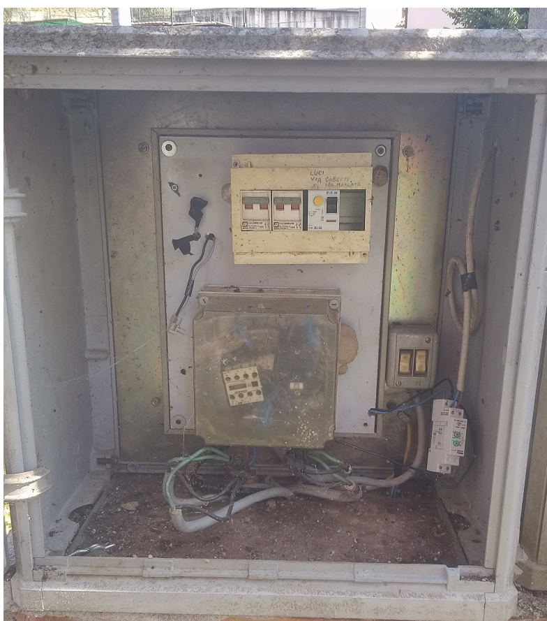
ESEMPIO DI QUADRO NON A NORMA E IN PESSIMO STATO
