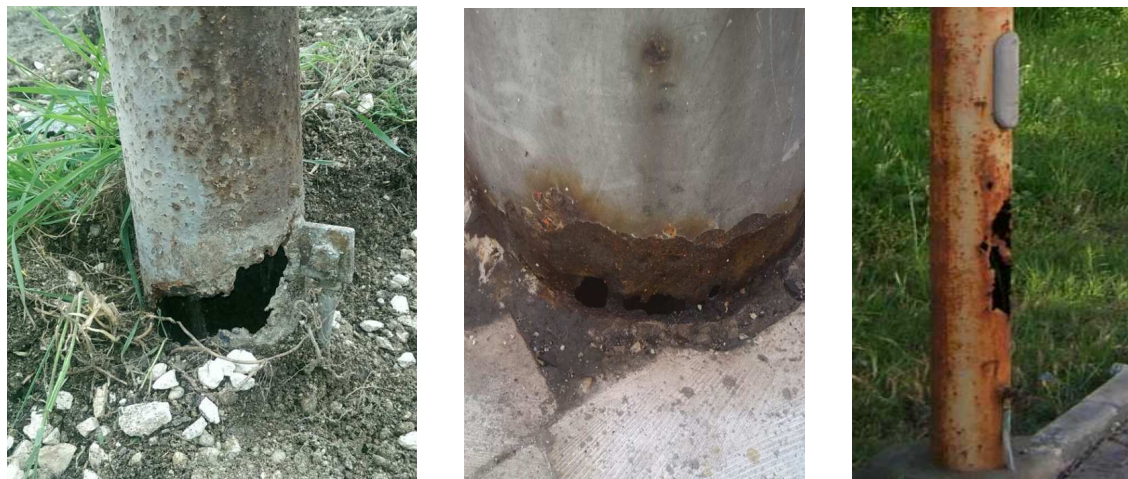
ESEMPI DI SOSTEGNI IN PESSIMO STATO E DA SOSTITUIRE
